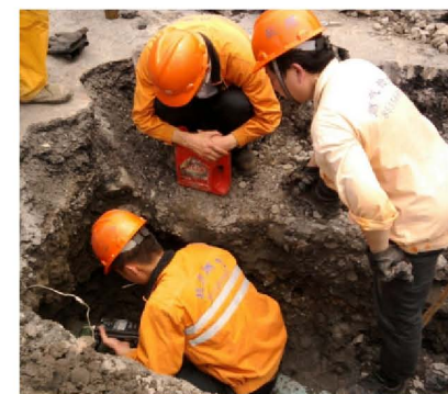
工作人员正在防腐检测
